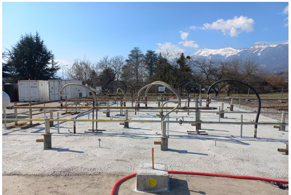
Figure 3 : limitation de l'impact par travaux in situ
