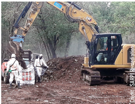
Excavation en conditions amiante
