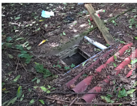
Exemple de plaque ondulée en cours d'enfouissement
