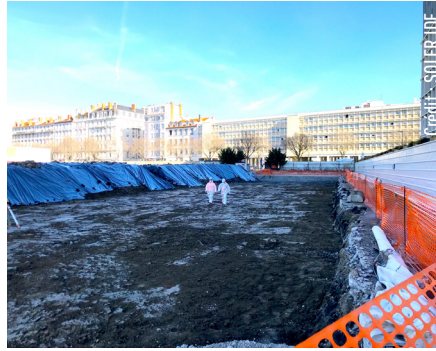
Chantier de dépollution avec amiante dans les terres
